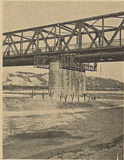
Abb. 26. Neue Überbauten mit Besichtigungswagen.
