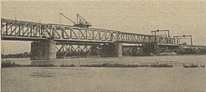
Abb. 13. Abbruch der Überbauten „a“.
