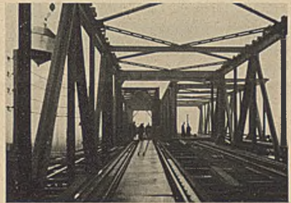
Abb. 21. Vor der Einschiebung des letzten Überbaues.
