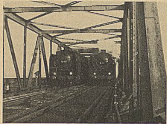
Abb. 24. Probebelastung.
