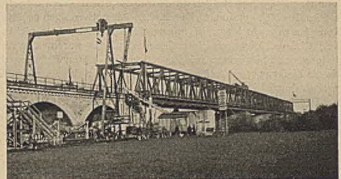
Abb. 22. Nach der Einschiebung des letzten Überbaues.
