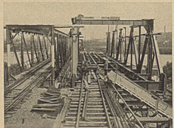
Abb. 16. Montage des ersten Überbaues.
