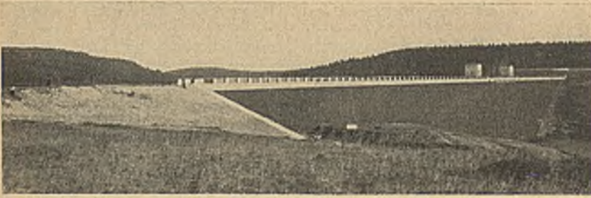
Abb. 18. Wasserseite der fertigen Mauer. Aufbringen der Steinschüttung auf den Erddamm.
