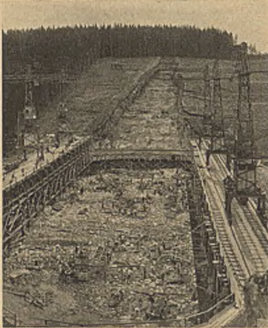
Abb. 7. Mauerarbeiten in der Talsohle, Arbeitsgerüste mit Transportkränen. Am rechten Hang Holzgerinne zur Überführung der Weißeritz während des Baues.
