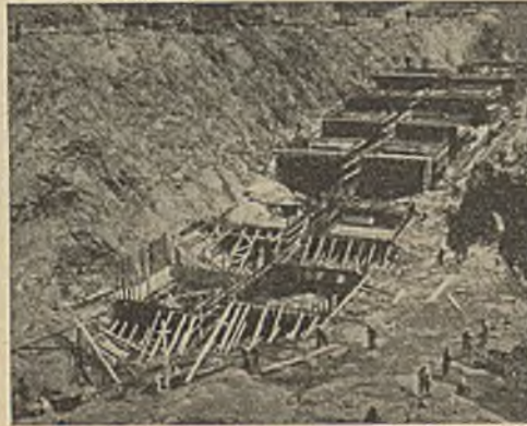
Abb. 2. Aufstellen der Schalung und Beginn der Betonierarbeit. Bauzustand Mitte Juni 1933.
