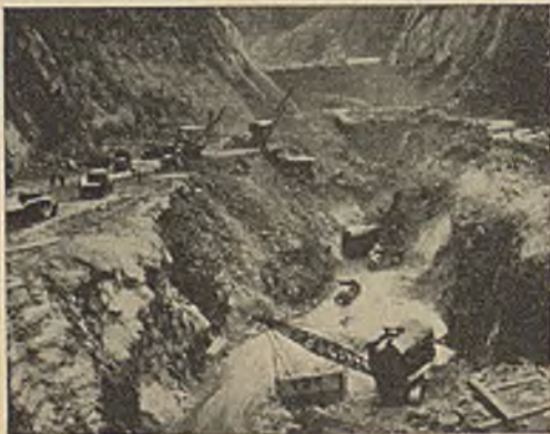
Abb. 1. Aushubarbeiten für die Gründung der Sperrmauer, Bauzustand am 1. Mai 1933.
