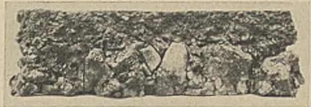
Abb. 2. Termakolit-Teerbeton auf Teermakadambinder (Ausbaustück).
