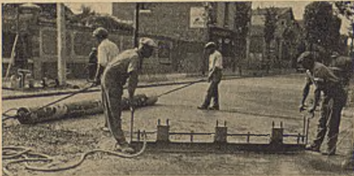
Abb. 3a. Zwei verschiedene Vibrationsverfahren.
