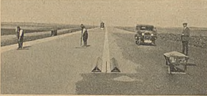
Abb. 3. Kraftwagenstraße Bonn-Köln. Aufbringen der Oberflächenbehandlung und Herstellen der Trennungstreifen. Baujahr 1931.
