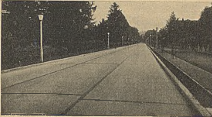
Abb. 5. Avenue des bains, Yverdon, Kt. Waadt, erstellt 1933, 9 m breit, Profiltyp IV.
