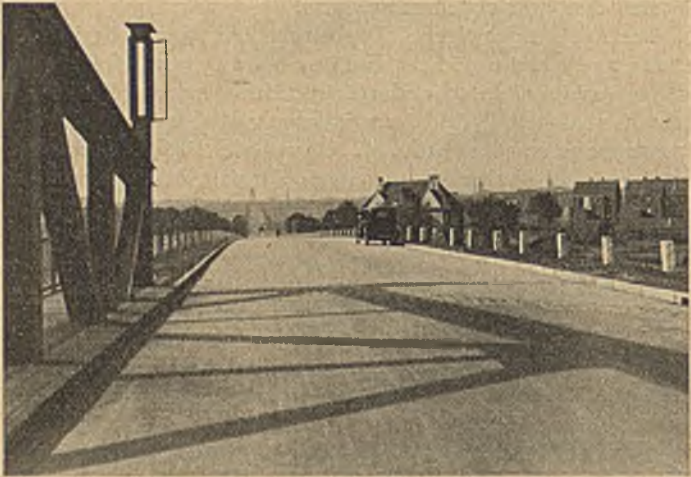
Abb. 6. Verbandsstraße O W IV in Dortmund. Fahrbahnbefestigung: Kleinpflaster und Teerbeton in 9 m Fahrbahnbreite,
