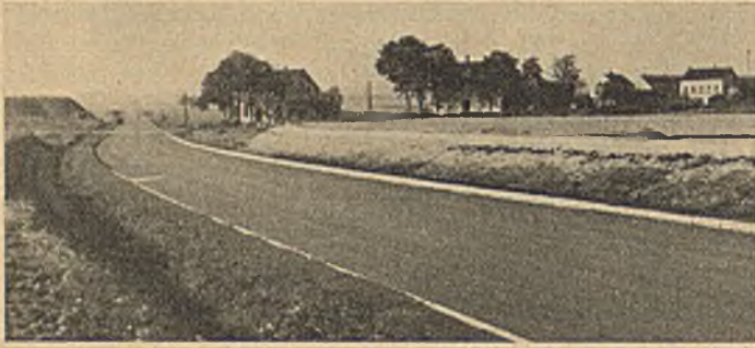
Abb. 5. Verbandsstraße O W IV in Dortmund. Vorläufige Fahrbahnbefestigung: Teereinstreudecke in 9 m Fahrbahnbreite.
