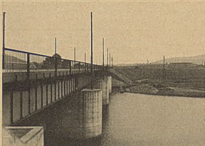
Abb. 10. Verbandsstraße O W V von Witten bis Hagen (Vorhalle). Kreuzungsbauwerk mit der Ruhr unterhalb des Harkortstausees bei Wetter.
