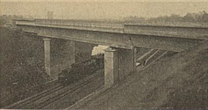
Abb. 12. Verbandsstraße D VI. Kreuzungsbauwerk mit der Reichsbahn. Baustoff: Eisenbeton. Statisches System: Gerberträger. Mittelöffnung 25 m. Seitenöffnung 2 \times 17,5 m. Fahrbahnbreite 9 m. Zwei Gehwege mit je 1,5 m.
