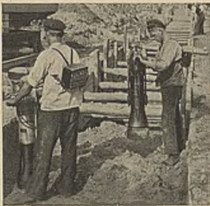
Abb. 6. Explosionsramme der Delmag A.-G., Eßlingen/Neckar, beim Verdichten geschütteten Bodens.
