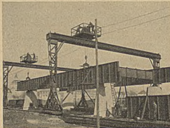
Abb. 3. Zwei Hauptträger mit Querträgern bei der Montage mittels zweier Portalkrane.
