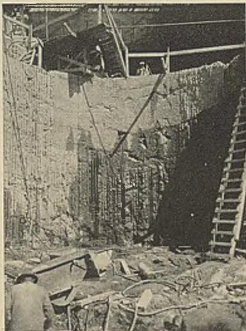
Abb. 22. Vargön. Wände des Saugrohres der westlichen Turbine direkt aus dem Felsen ausgearbeitet.
