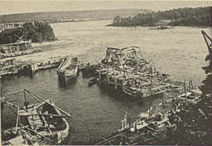
Abb. 33. Vargön. Ein eiserner Bock des unterwasserseitigen Fangdamms wird an Ort und Stelle gebracht. Betonieren unter Wasser bei den schon angebrachten eisernen Böcken.
