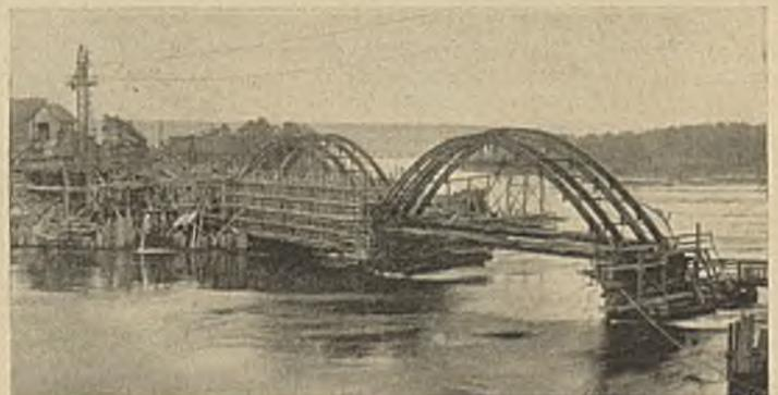
Abb. 31. Vargön. Gerüste und Schalungen für die Teile der Einlaufdecken, die vor dem Bau des Fangedammes gegossen wurden.
