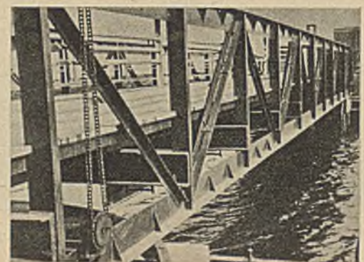
Abb. 4. Ansicht des geschweißten Hauptträgers.
