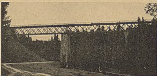
Abb. 4. Regenbrücke bei Regen, km 111,123.
