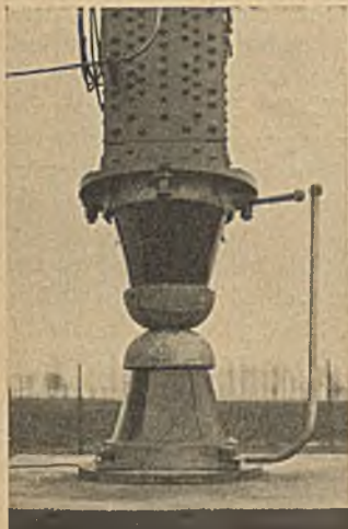
Abb. 4. Der Grundisolator.
