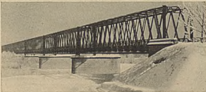
Abb. 2. Donaubrücke bei Deggendorf, km 71,188.
