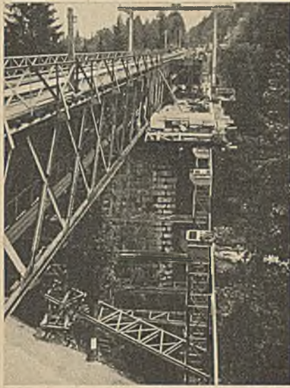
Abb. 7. Ansicht und Montage der Regenbrücke bei Fällerechen, km 123,200.
