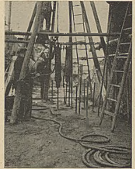
Abb. 6. Rammen der Spritzrohre.
