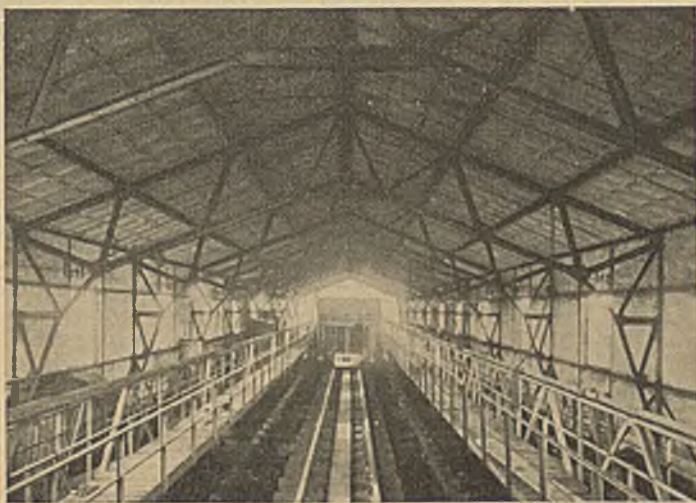
Abb. 1. Innenansicht der ursprünglichen Konstruktion.
