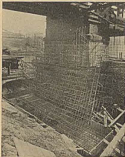
Abb. 8. Bewehrung des Pfeilerschaftes.
