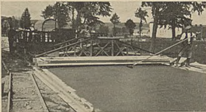
Abb. 3. Hammerstampfmaschine und Straßenfertiger in Zwillingsanordnung bei Strecke I.
