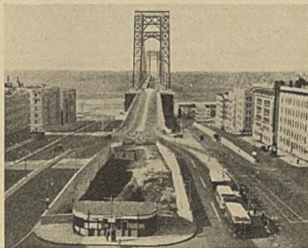
Auffahrt zur George-Washington-Brücke auf der New Yorker Seite. (Etwa in der Mitte des Bildes sieht man den durch ein x bezeichneten Gefahrenpunkt an der Northern Avenue, wo ein großer Teil des Verkehrs um 180° wenden muß.)
