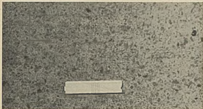
Abb. 6. Oberflächenbeschaffenheit der Strecke II. (Als Vergleichsmaßstab ein kleiner Taschenrechnerschieber von 12,5 cm Länge.)
