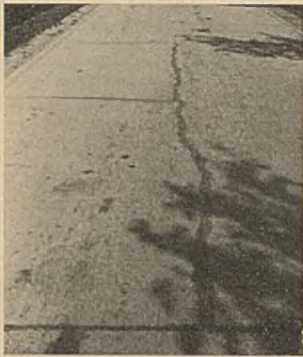
Abb. 9. Primärer Längsriß, sekundärer Querriß auf der Straße Kattowitz—Sorau.
