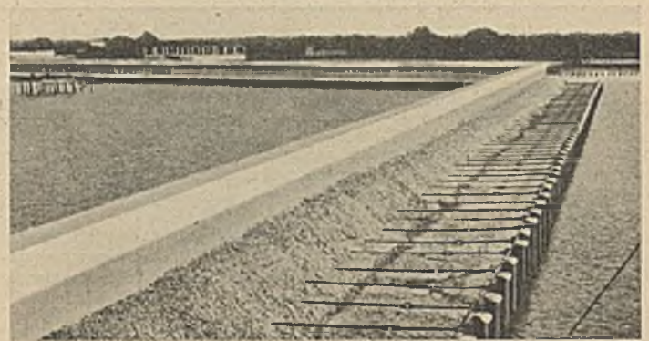
Abb. 3 a. Einfache Spundwand.
