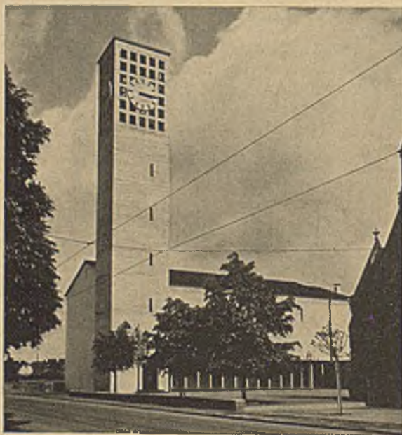
Abb. 4. Nord-West-Ansicht. (Photo, Spreng, Basel.)
