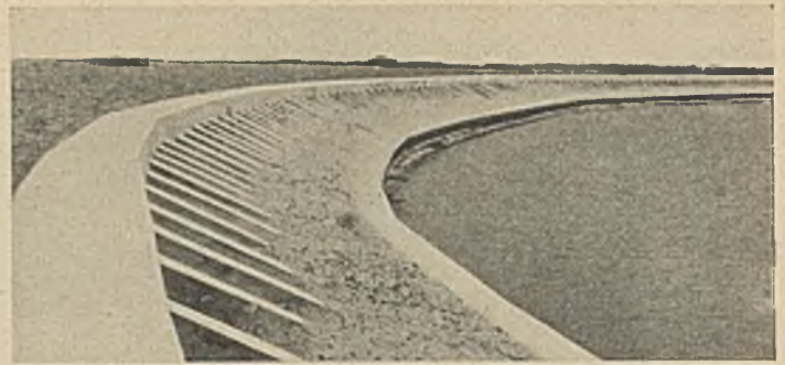
Abb. 2 a. Doppelte Spundwand mit Erdkern.
