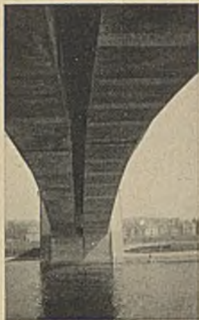
Abb. 7. Untersicht des rechten Bogens.
