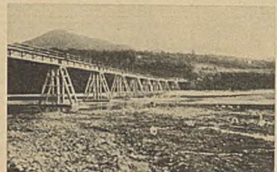
Abb. 3. Dienstbahn. Brücke in Eisenbeton über den Reno.
