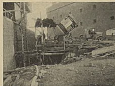
Abb. 13. Entleerung des Mixers in den Aufzugskübel der Gießanlage (südl. Brückenendpfeiler).
