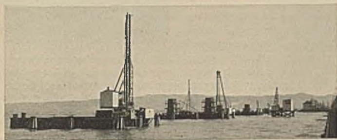
Abb. 7. Pfeiler für die 91 m-Brücken im Bau. Stand vom 26. 1. 34.
