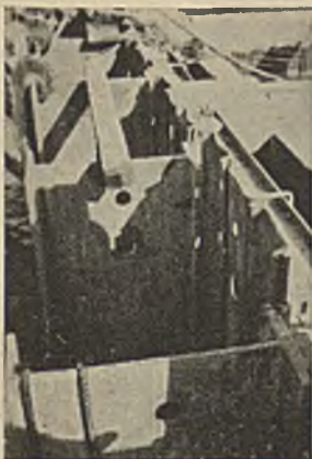
Abb. 8. Detail der Spundwand für die Baugruben in der Ostbay. Aufgenommen 5. 3. 34.
