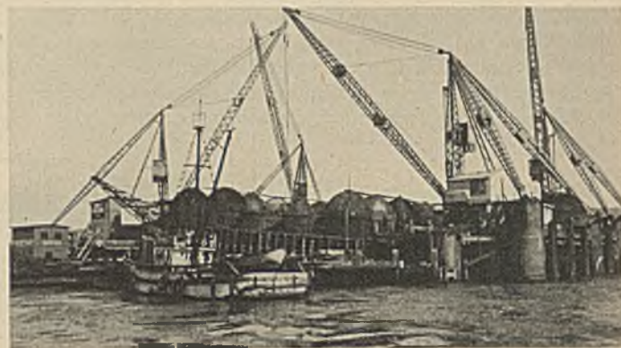
Abb. 4. Aushub an der Nordseite des Caissons von Pfeiler 4. Stand vom 16. 2. 34.
