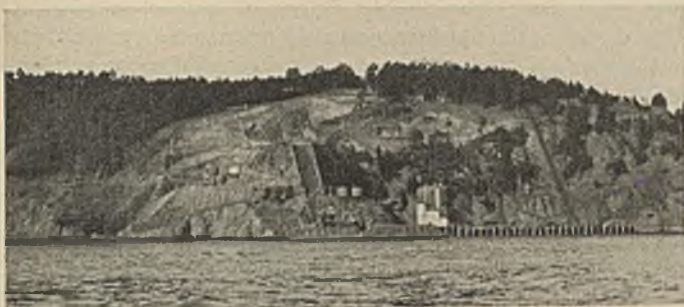
Abb. 6. Yerba Buena Island. Tunnleinschnitt, Materialrutsche und sonstige Installationen.
