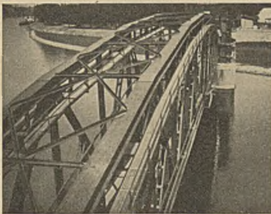
Abb. 5. Oberer Besichtigungssteg mit Obergurt.
