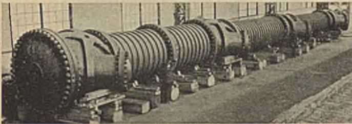
Abb. 14. Bandagierte Druckrohrleitung. (Vermount).
