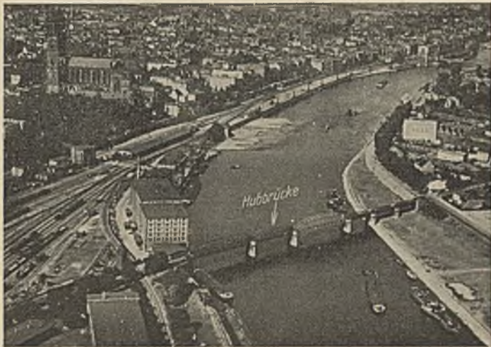
Abb. 1. Gesamtansicht vor dem Umbau.
