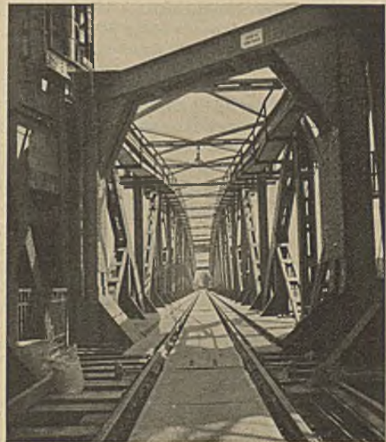
Abb. 6. Fahrbahnabdeckung.
