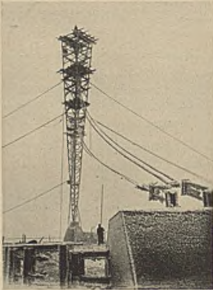
Abb. 1. Unterer Mastteil während der Montage.
