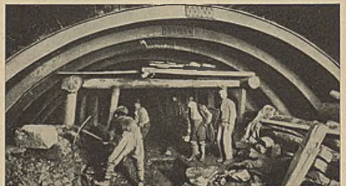
Abb. 11. Einrüstung der Kalotte mit eisernen Lehrbögen.
