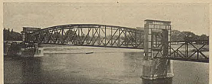
Abb. 16. Brücke in gehobener Lage.
