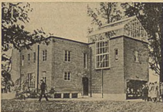
Abb. 5. Das fertige Stahlhaus.
