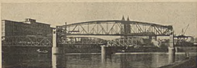
Abb. 13. Abbruch der alten Überbauten.
