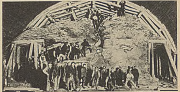
Abb. 10. Einrüstung der Kalotte und Aushub der Widerlager.
