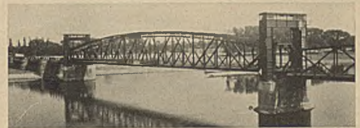
Abb. 15. Brücke in gesenkter Lage.
