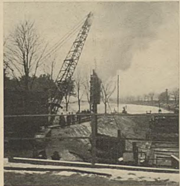
Abb. 2. Rammen der Schleusenwände der Schleuse Bischofswerder am Voßkanal.
