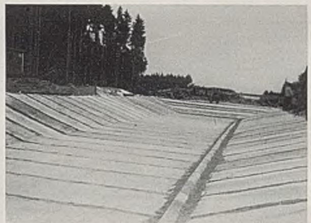
Abb. 14. Der mit Bitumenbahnen versehene Koffer vor dem Einbringen der Lößlehm Massen.
