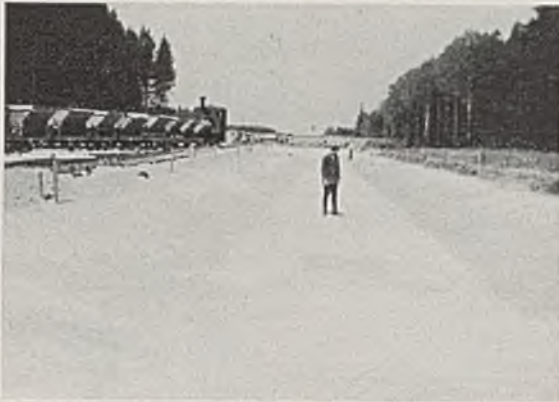
Abb. 10. Ausgekoffter Streckenabschnitt vor Einbau der Bitumengewebebahnen.
