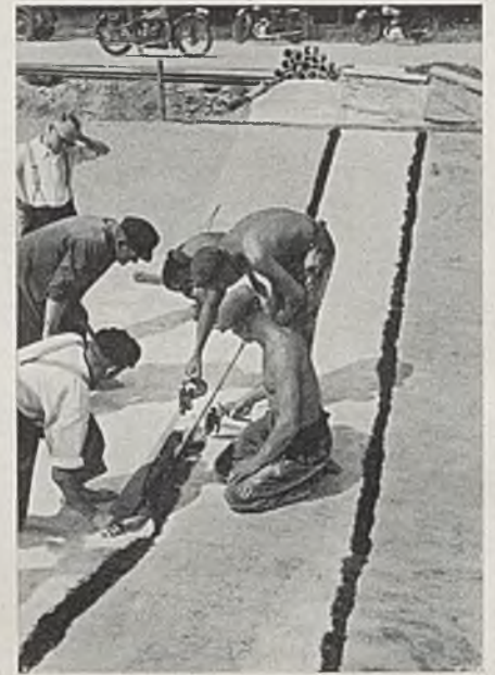
Abb. 13. Richtiges Verbinden der Bitumengewebebahnen.
