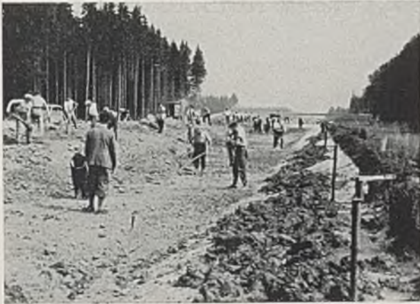
Abb. 15. Auffüllen des mit Bitumenbahnen versehenen Koffers mit LÖB lehm Massen.
