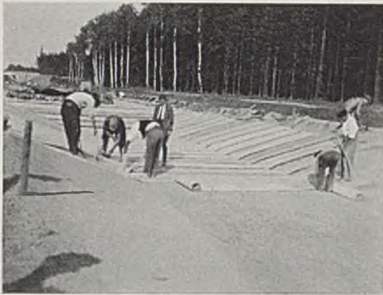
Abb. 11. Legen der Bitumengewebebahnen.
