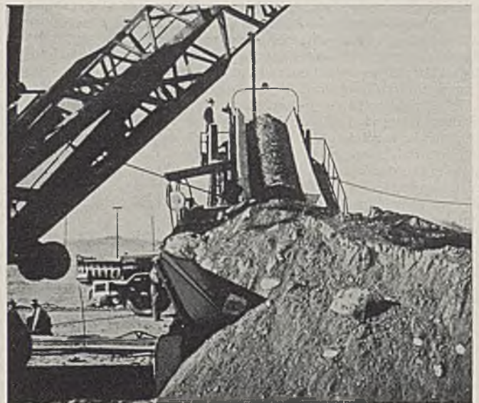
Abb. 4. Hansen-Walzdamm in USA. Bunkermaul des Bunkertaschenbandbeschiekers.
