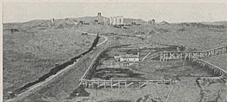
Abb. 4. Wiederherstellung und Verstärkung des Fort Peck Staudammes.
