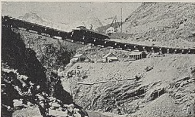
Abb. 6. 85 m lange Zweikabelbrücke für 20 t Lastwagen.
