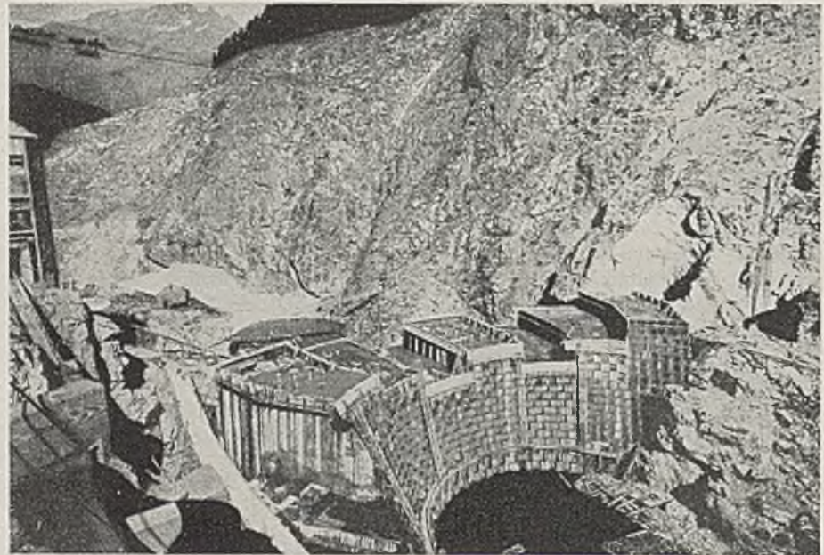
Abb. 3. Roß-Bogenstaumauer. Herstellung der Blöcke.
