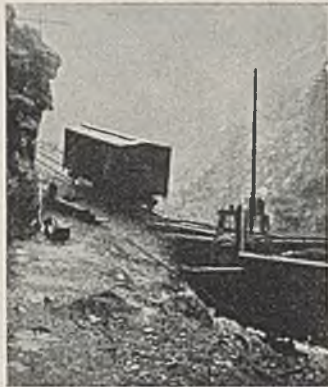
Abb. 5. Waggon-Fährboot und Schrägaufzug für die Zementanlieferung.
