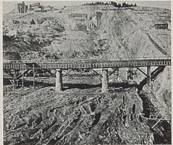
Abb. 5. Gerinne am rechten Ufer. — Die Gründungssohle ist zum Betonieren vorbereitet (September 1937).
