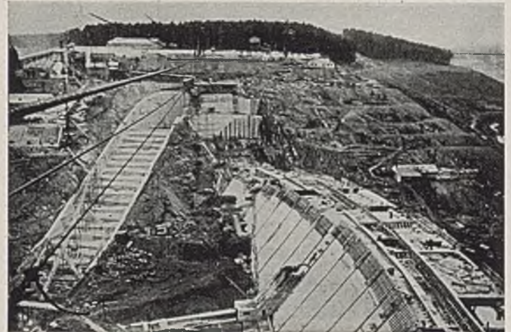
Abb. 7. Übersicht über die Baustelle im November 1939. Die Hochwasserentlastungsanlage ist bereits fertiggestellt.
