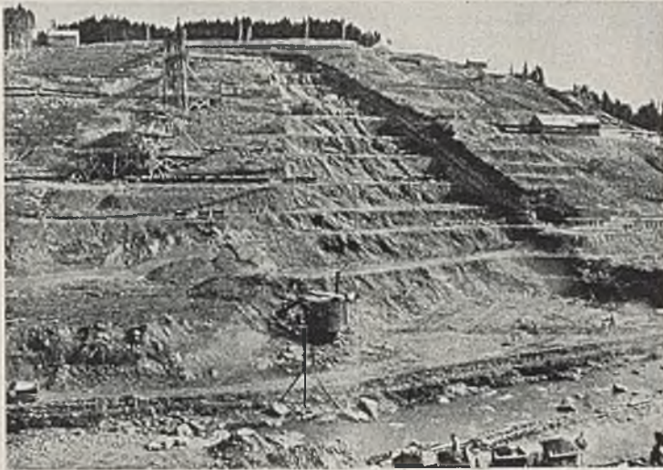
Abb. 4. Überblick über den Hangaushub (rechtes Ufer). Angriffsstellen in verschiedenen Höhen (März 1937).
