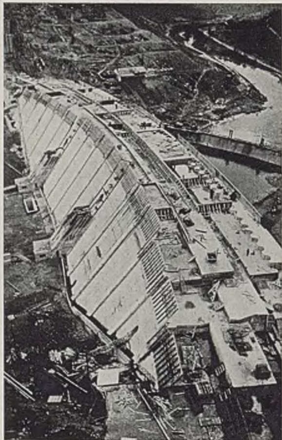
Abb. 2. Eupener Talsperre. Blick vom linken Ufer. Man sieht die starke Verzahnung sowohl in vertikaler als auch in horizontaler Richtung.
