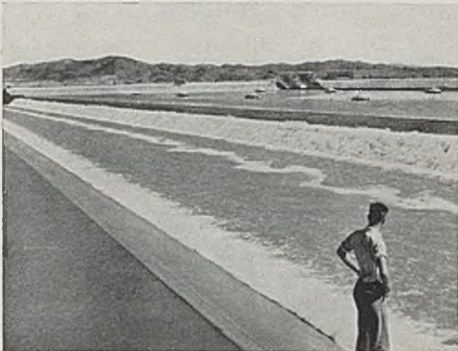
Abb. 4. Imperial-Stauanlage. Sammelkanal für das Überströmwasser der Absitzbecken.
