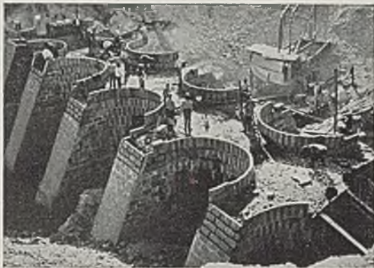
Abb. 5. Pego do Altar-Talsperre. Fangedamm zur unterwasserseitigen Abriegelung der Baugrube.
