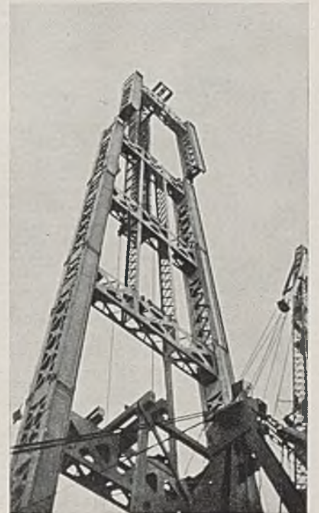
Abb. 2. Pylon im Bau.
