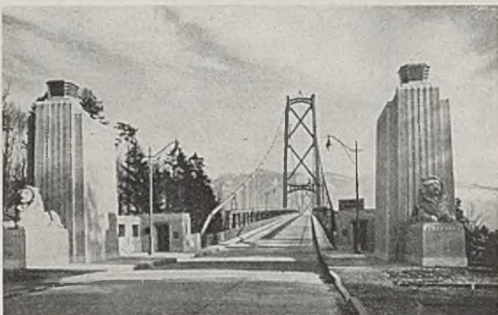
Abb. 2. Blick auf das Südende der Brücke.
