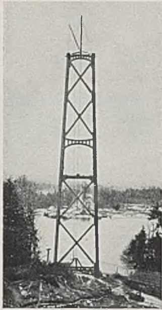
Abb. 3. Südlicher Pylon im Bau.
