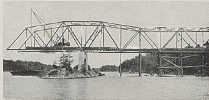
Abb. 4. Fachwerkbrücke im Bau.
