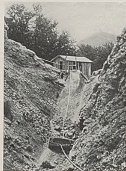
Abb. 1. Schrapper der Demag AG. beim Herstellen eines Einschnittes.
