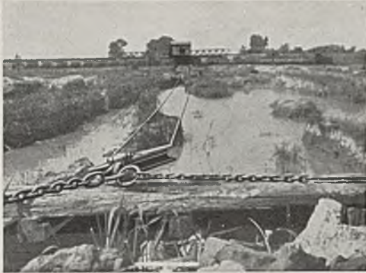
Abb. 3. Seilablenkrolle am Ende der Förderbahn eines Schrapppers der Hasenclever AG.
