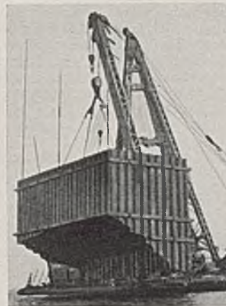
Abb. 2. Absetzen des Senkkastens mit dem Schwimmkran.
