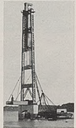
Abb. 3. Zusammenbau des Pylons. Kletterkran in höchster Stellung.
