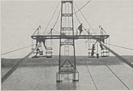
Abb. 4. Einbau der Kabelschellen vom Montagegerüst aus.
