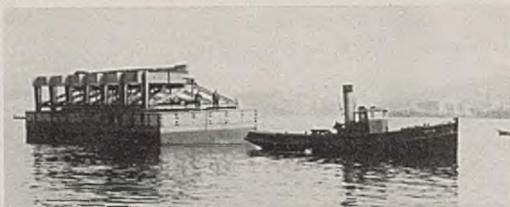
Abb. 58. Einschwimmen des Pontons I.
