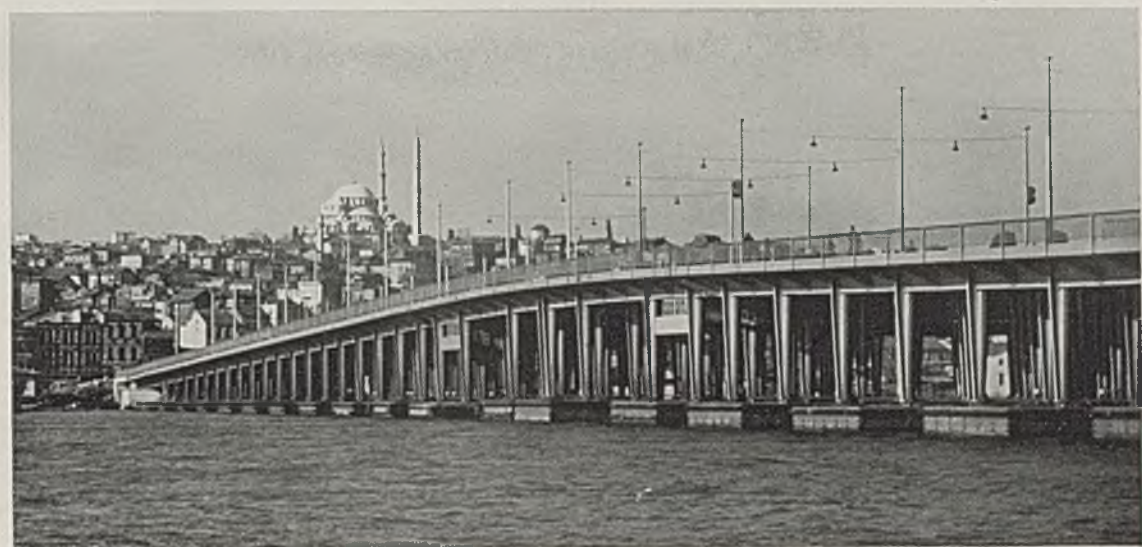
Abb. 65. Brückenansicht vom Ufer Azap-Kapou.
