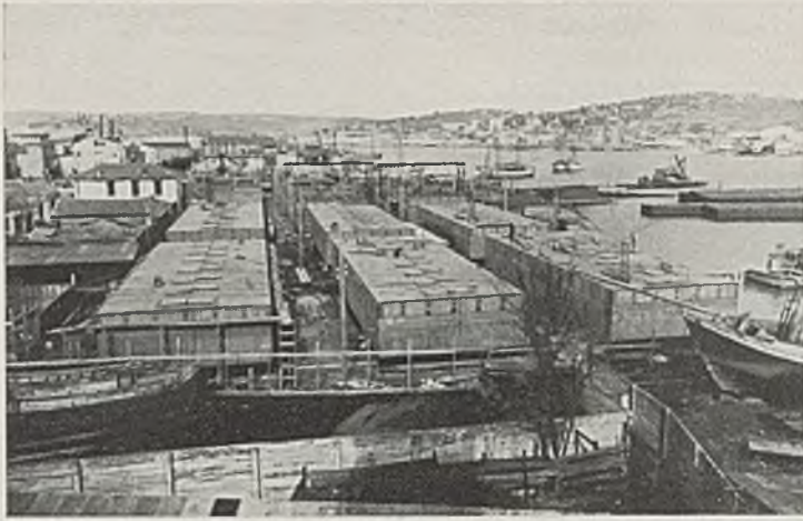
Abb. 55. Übersicht über den Pontonbauplatz.
