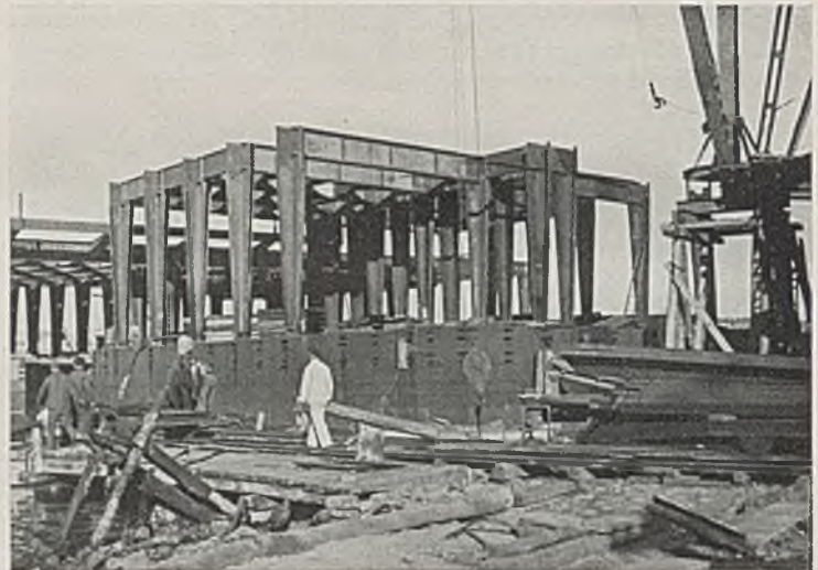
Abb. 60. Montage des Überbaus auf Ponton XII und XII'.
