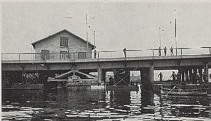
Abb. 48. Auswechslung des Pontons I.
