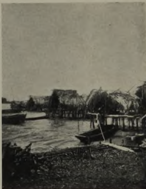
Budowle palowle Indian na wybrzeżach zatoki Maracaibo w Wenezueli.
