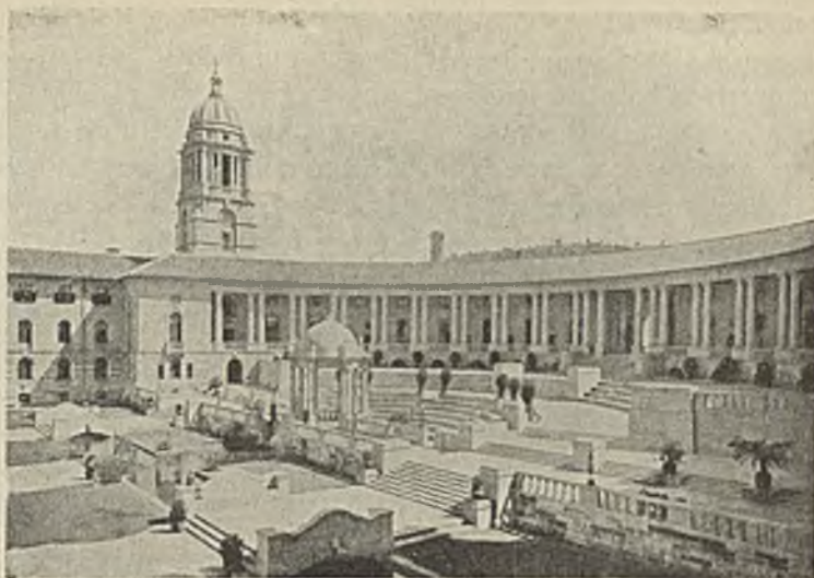
Część środkowa administracyjnego Gmachu Unji, „Union Buildings“ w Pretorji, z amfiteatrem.
