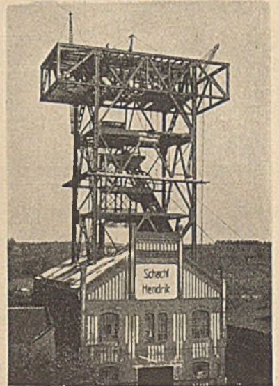
Abb. 10. Aufstellung des Turmes bei vollem Betrieb der alten Anlage.
