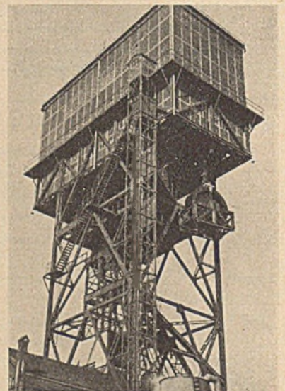
Abb. 11. Hochziehen des Ankers des Fördermotors mit Hilfe des 35 t-Laufkranes des Maschinenhauses durch die Montageöffnungen hindurch.
