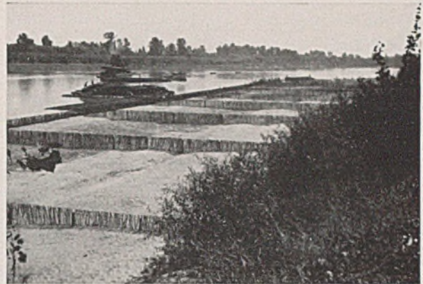
Abb. 12. Flechtzäune zur Befestigung von Sandbänken am einbuchtenden Ufer.
