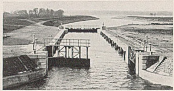
Abb. 8. Schiffschleuse bei Tass. (85 × 12 m.)
