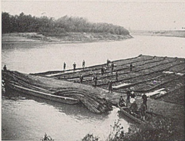
Abb. 9. Faschinenmatratze an der Tisza.
