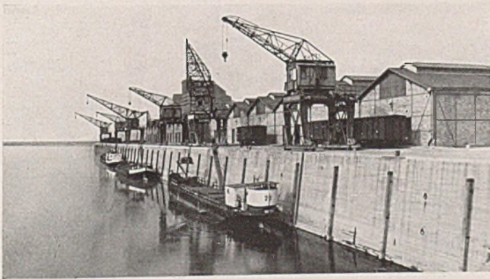
Abb. 4. Die Kaimauer des Budapester Freihafens.
