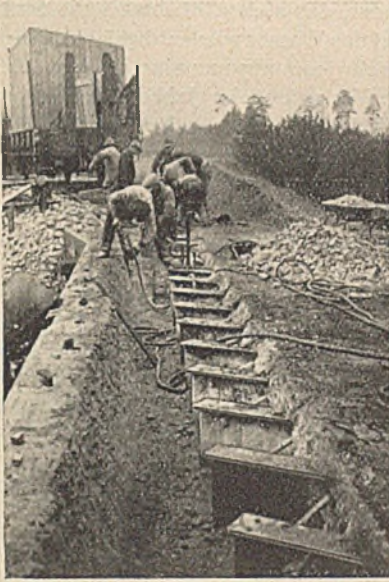
Abb. 13. Hebung der Bahnüberführung in km 54,403 Treuchtlingen—Nürnberg. Freilegung der Trägerenden.
