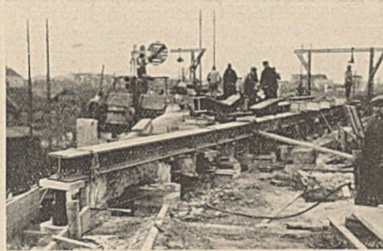
Abb. 14. Hebung der Bahnüberführung in km 54,409 Treuchtlingen—Nürnberg. Ansicht des Hubträgers.
