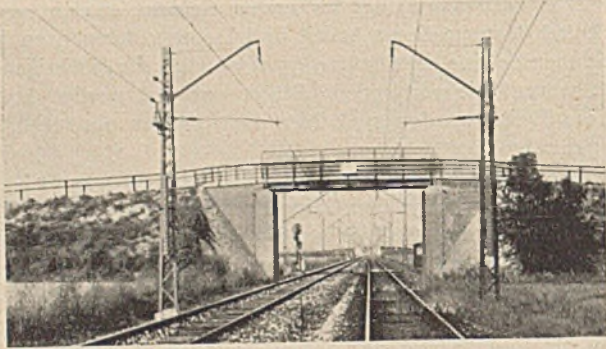
Abb. 8. Umgebaute Wegüberführung (früher gewölbt).
