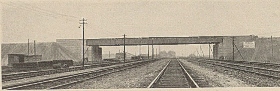
Abb. 7. Ansicht des fertigen Bauwerks.
