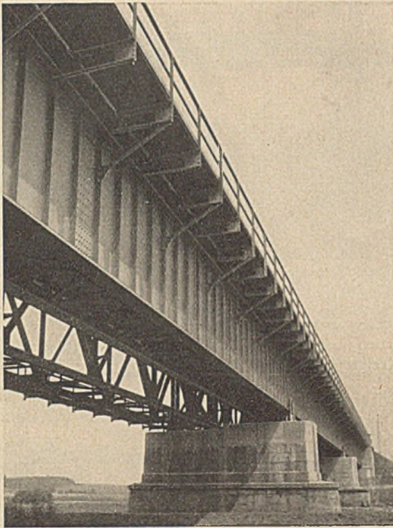
Abb. 6. Altmühlbrücke bei Gstadt. Fertige Brücke.
