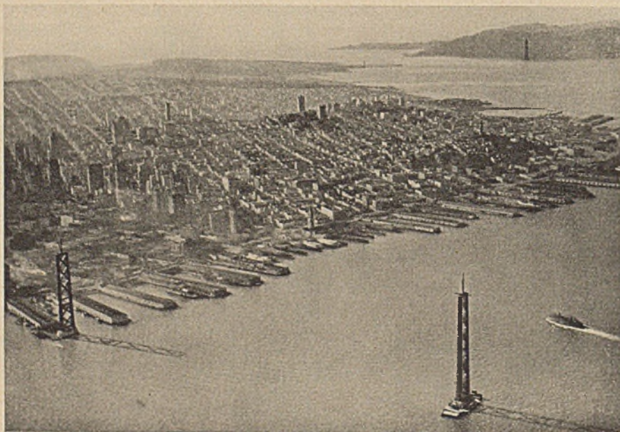
Abb. 4. Zwei Türme der Hängebrücke in der Westbucht. Im Hintergrund (oben rechts) ein Pylon der Golden Gate Bridge im Bau.
