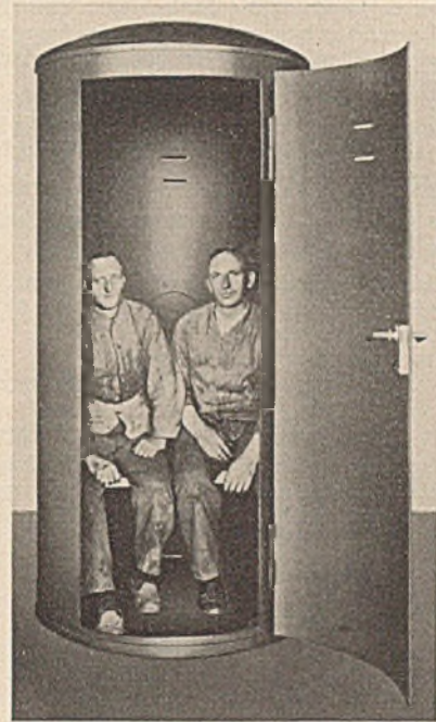
Abb. 3. Stahlzelle für Notbelegschaften zum Schutz gegen Trümmer und Splitter.
