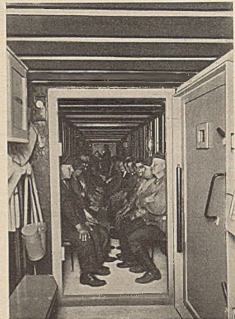
Abb. 1. Belegschaft im Schutzraum aus Stahlpundbohlen.
