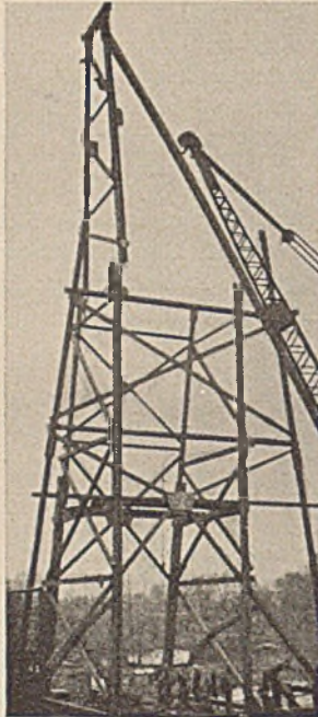
Abb. 4. Zusammenbau eines Turmes mittels Schwimmderrick aus einzelnen Abschnitten.
