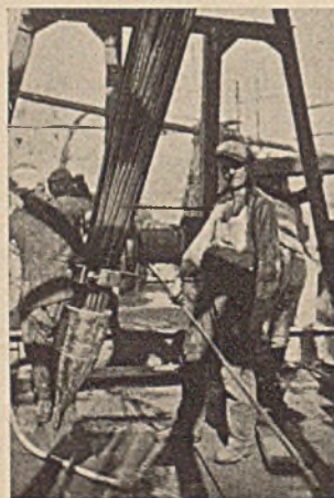
Abb. 9. Kabel, fertig zum Ablassen.
