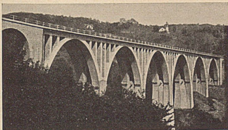
Abb. 4. Talübergang bei Montanesi (6 × 25,5 m + 4 × 10 m).
