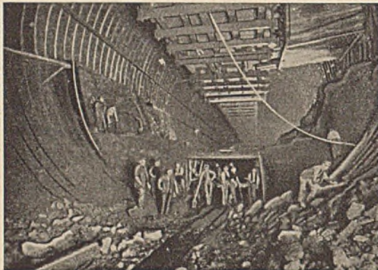
Mersey-Tunnel während des Vollaussbruchs.
