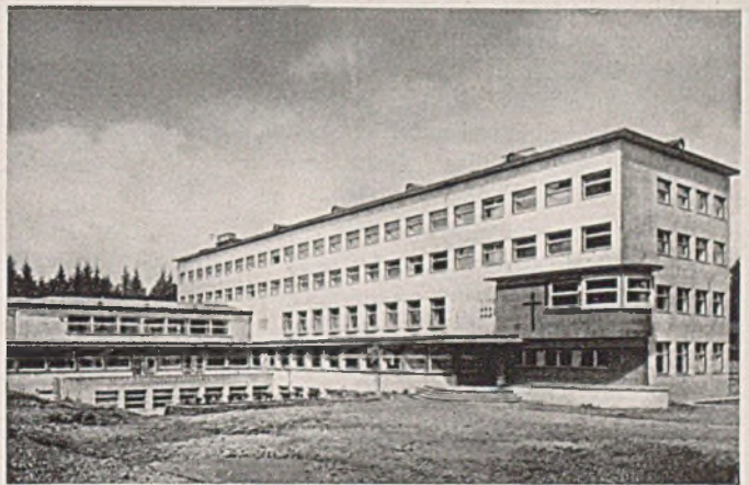
Abb. 21. Fertiges Bauwerk. Haus Neuvandenburg.
