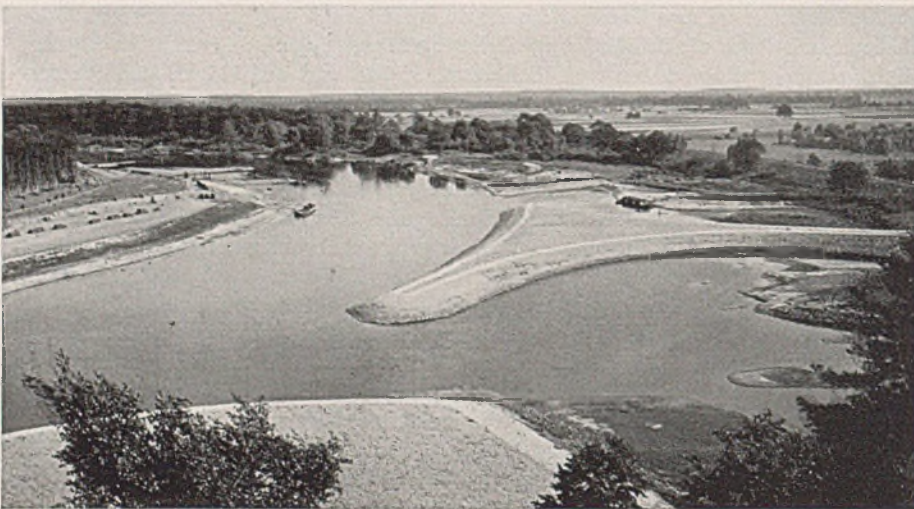
Abb. 13. Abflachung der Oderkrümmung am Weißen Berge unterhalb Glogau. (Am einbuchtenden Ufer ist die mit Kalkstein abgedeckte Spülfläche des Deckwerkes und die fertiggestellte Hammerbuhne zu erkennen. Den früheren Zustand zeigt Abb. 5.)
