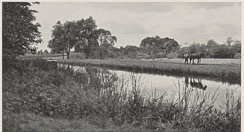
Abb. 22. Alter Klodnitzkanal mit Pferdetreidelbetrieb. (Die Wasserspiegelbreite dieses über 115 Jahre alten Schifffahrtsweges beträgt 12 m, der Wasserquerschnitt 15 m^2 .)
