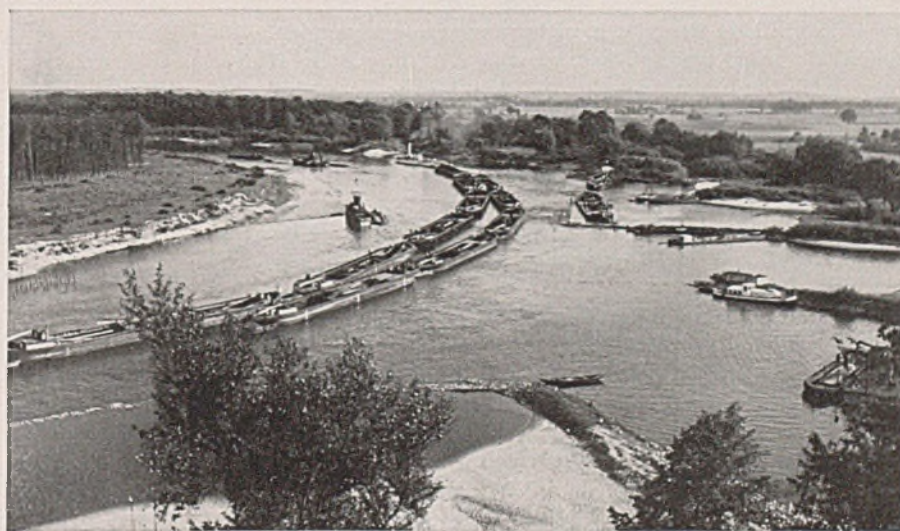
Abb. 5. Bergschleppzug mit 11 Leerkähnen in der Oderkrümmung am Weißen Berge rd. 50 km unterhalb Glogau. (Am ausbuchtenden Ufer sind Baggerungen zur Abflachung der Krümmung im Gange.)
