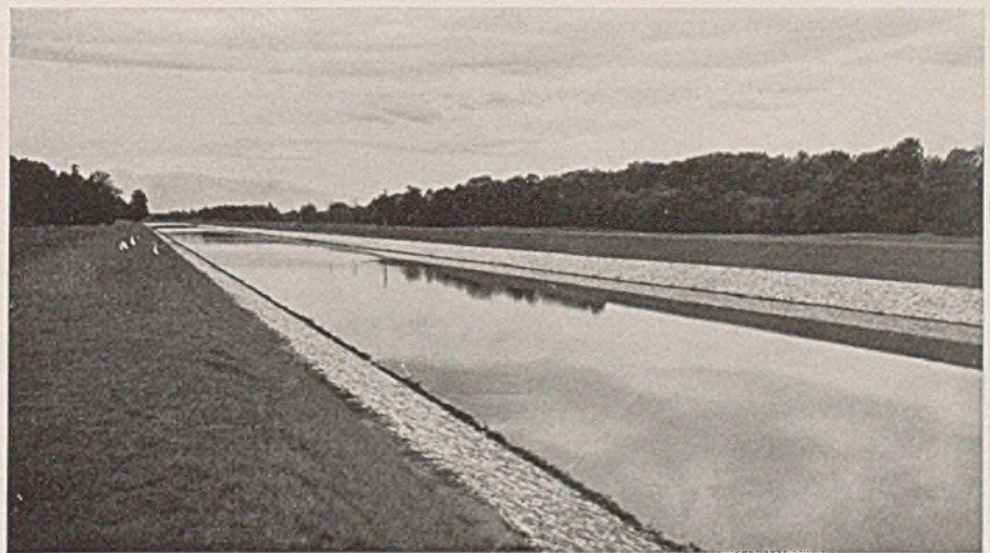
Abb. 26. Blick auf eine fertiggestellte Teilstrecke des Adolf Hitler-Kanals bei Ehrenforst (km 14,0).
