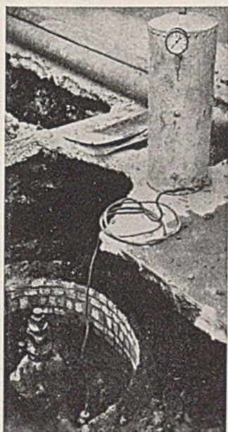
Abb. 1. Einbringen der Farbstofflösung in die zu untersuchende Rohrstrecke.
