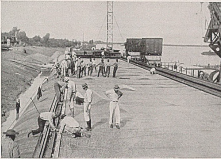
Abb. 1. Herstellung von Asphaltmatratzen.
