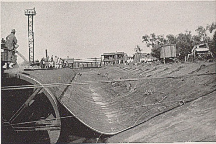
Abb. 2. Verlegung der Asphaltmatratzen durch Abrutschen.
