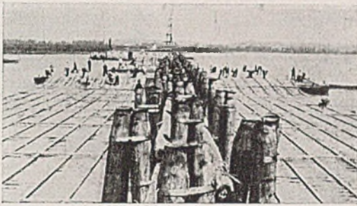
Abb. 4. Pfahlbockbühne mit seitlichen Bretter-Matratzen.
