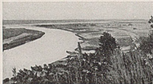
Abb. 1. Oben: Fertige Pfahlbockbuhnen. Mitte: Anlandung 5 Monate später. Unten: Das Flußbett nach 2 Jahren.
