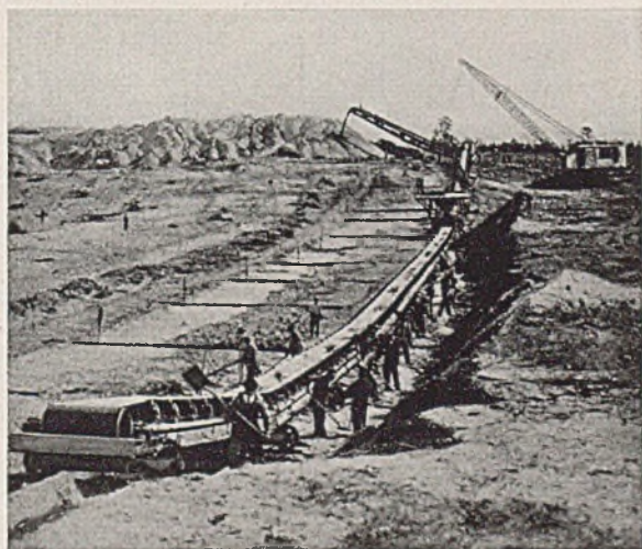
Abb. 8. Förderband beim Bau des Florida-Kanales.
