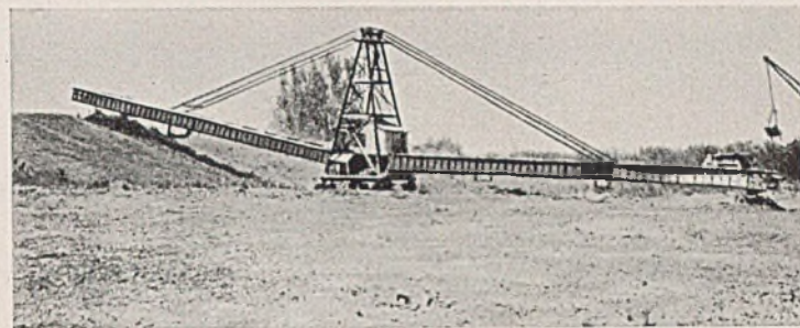
Abb. 9. Förderbrücke vom Deichbau am Mississippi, Gesamtlänge 110 m. Der Wagen (rechts) faßt 7,5 m 3 .
