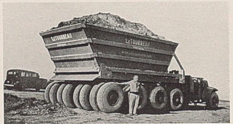
Abb. 6. Anhängewagen von 27 m 3 Fassungsvermögen auf 24 Gummirädern.
