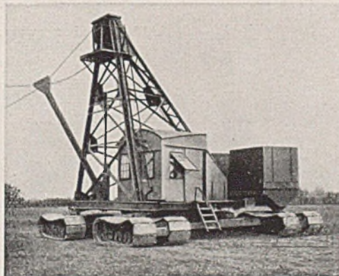
Abb. 2. Pendelturm eines Kabelbaggers, auf Raupen laufend.
