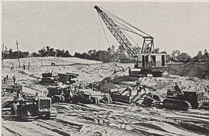
Abb. 7. Neuzeitliche Erdbaugeräte am Florida-Kanal. Im Vordergrund gummibereifte Schürfwagen, von Raupenschleppern gezogen. Dahinter Eimerseilbagger beim Beladen eines Raupenwagens.
