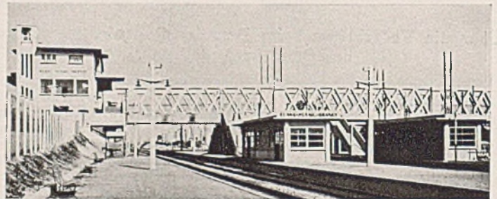
Abb. 1. Gesamtansicht der Überführung.
