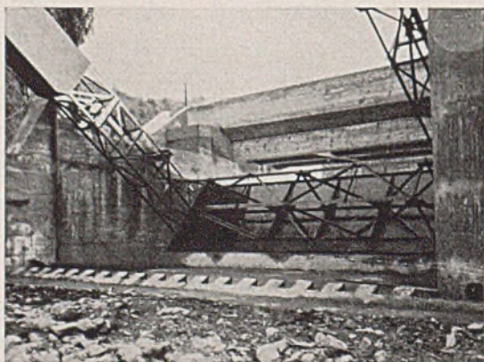
Abb. 11. Eingebaute Rehbock-Zahnschwellen am Wehrbodenende der Altmühl-Stauanlage Kratzmühle; die Zahnschwelle ist wie bei der Stauanlage Walting nicht am äußersten Wehrbodenende angebracht. (Kulturbauamt Weißenburg.)
