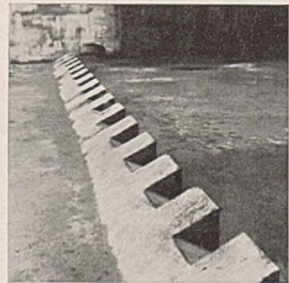
Abb. 8. Eingebaute Rehbock-Zahnschwellen an der Altmühl-Stauanlage Kratzmühle. (Kulturbauamt Weißenburg.)
