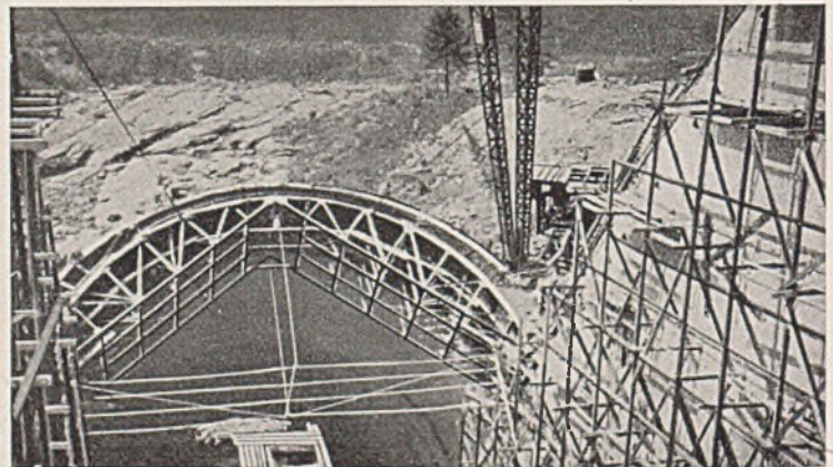
Abb. 4. Viktoria-Staumauer. Gewölbherstellung.
