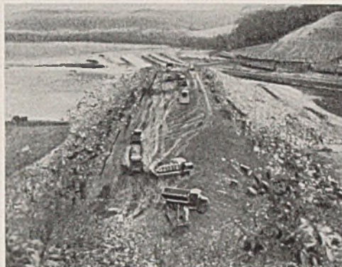
Abb. 3. Schütten und Verfestigen der Dämme.
