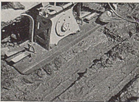
Abb. 4. Verdichten des Betons durch Oberflächenrüttler.
