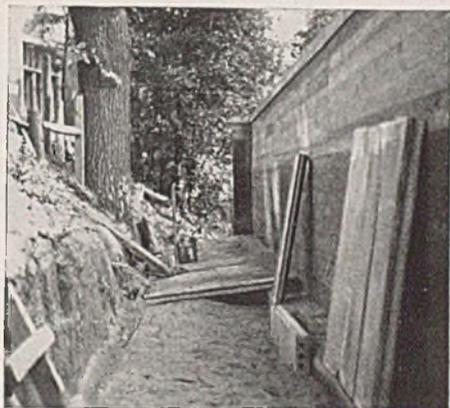
Abb. 2. Gitterwandplatten aus fertigen Eisenbetondielen. Ausführung 1935.
