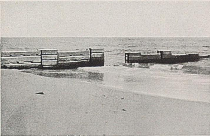
Abb. 1. Bühne aus Eisenbeton an der Küste von Florida.
