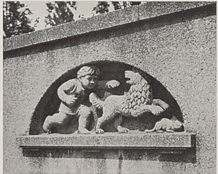
Abb. 8. Straßenbrücke über die Eisenbahn in Rosenstein in Stuttgart. (Baujahr 1913.) Bildwerk aus dem Beton herausgehauen.
