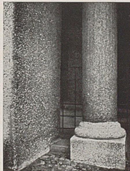
Abb. 9. Stampfbetonwände und Säulen am Portal der Ulmer Garnisonkirche.
