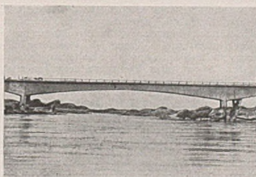
Abb. 4. Der Überbau von 70 m Stützweite.
