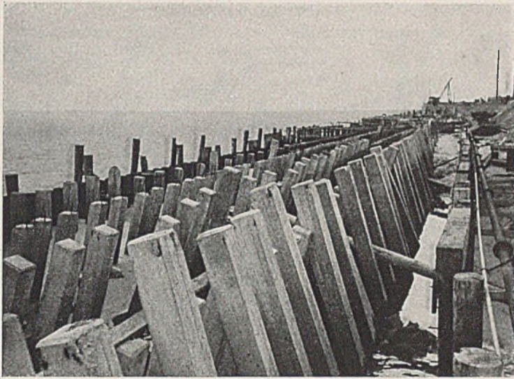
Abb. 5. Der fertiggerammte Unterbau.
