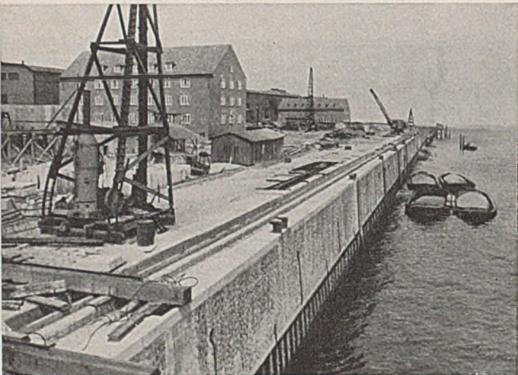
Abb. 9. Ansicht der teilweise fertigen Mauer.
