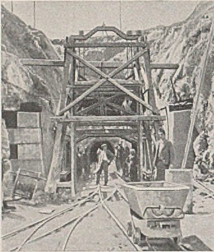
Abb. 2. Nordmund des Tunnels bei Mosul im Bau.
