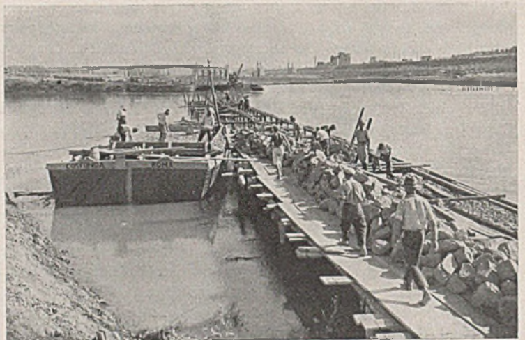
Abb. 10. Dammbau durch das alte Flußbett. Fot. Vasari, Rom.
