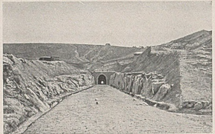
Abb. 4. Stützung des Tunnelfirsts mit Eisenbahnschienen.
