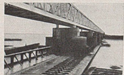
Abb. 5. Ansicht des Stauwehres vor Einbau der Klappen.
