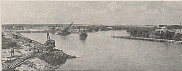
Abb. 11. Abzweigung des neuen Wasserlaufs und Wehrbau durch den alten Flußlauf.
