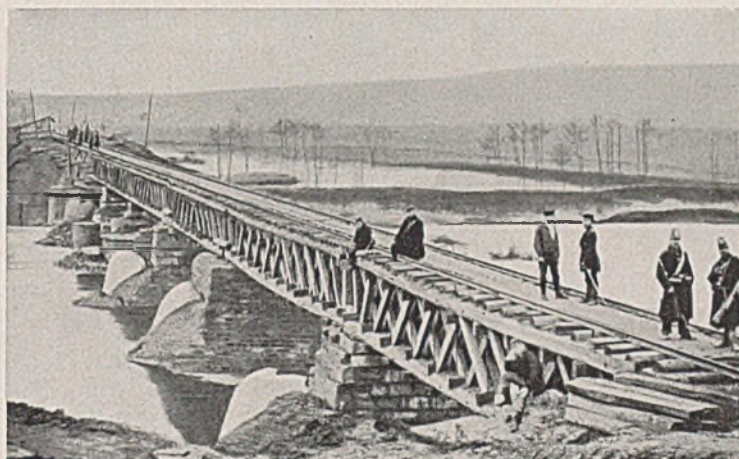
Abb. 20a. Moselbrücke bei Langley (1870). 7 Öffnungen von 16—21 m Stützweite.
