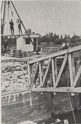
Abb. 24. Feldmäßiger Einbau eines genagelten Brückenträgers.
