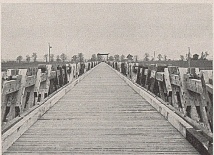
Abb. 23. Holzfachwerkbrücke in fertigem Zustande.
