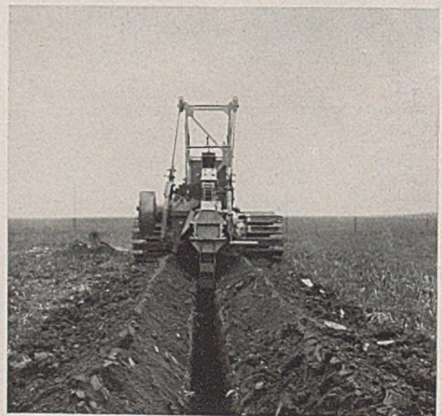
Abb. 6. ATG-Grabenfräser beim Ziehen eines Grabens.
