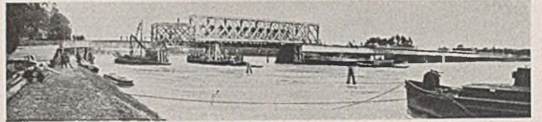
Abb. 25. Straßenbrücke in genagelter Bauweise über einen großen Strom. Einfahren der Fachwerkträger für die Schiffsöffnungen — 50 m Spannweite.
