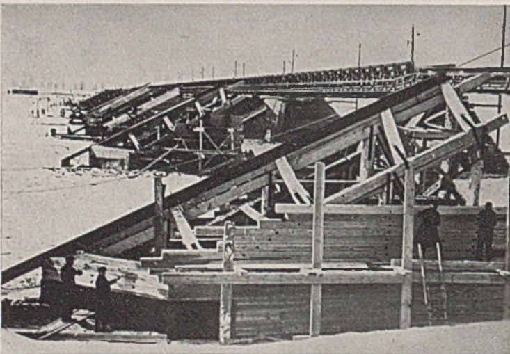
Abb. 18. Eisbrecher im Bau.
