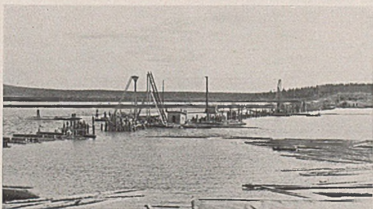
Abb. 21. Eisenbahnbehelfsbrücke aus Holz; 300 m lang. 1870.
