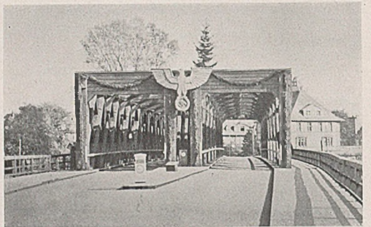
Abb. 26. Blick auf die Endrahmen der fertigen 50 m Fachwerkbrücke.
