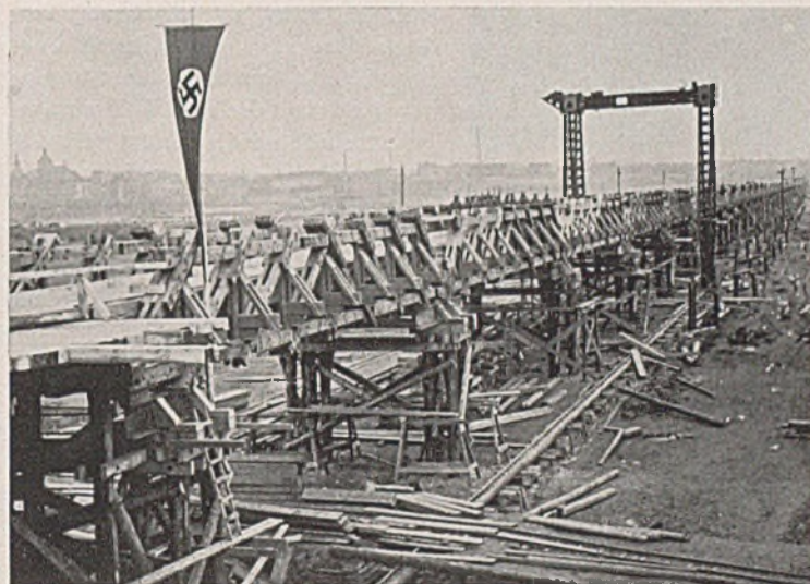
Abb. 22. Einbau von Holzfachwerkträgern in neuzeitlicher Bauweise mit Hilfe eines zerlegbaren Portalkrans.
