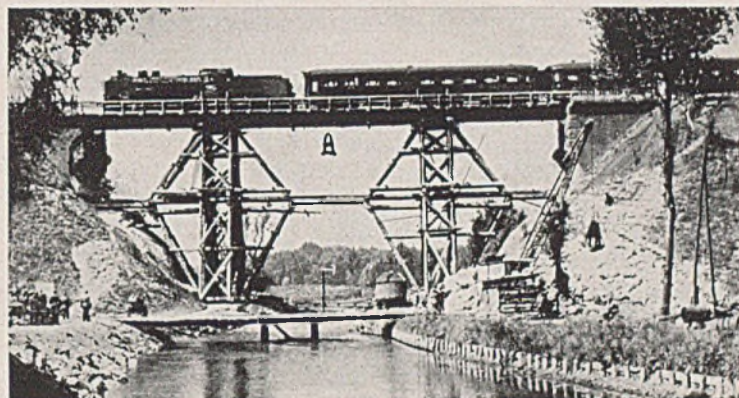
Abb. 15. Eisenbahnbehelfsbrücke über einen Flachlandfluß. Ersatz für eine gesprengte Massivbrücke.
