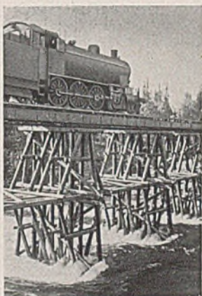
Abb. 14. Ansicht der Brücke von der Seite.
