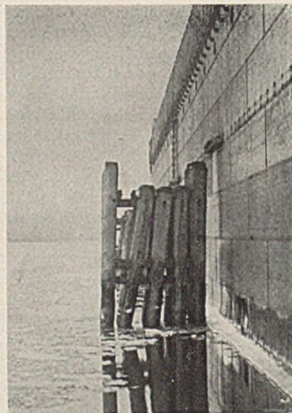
Abb. 21. Führungsdalben an einem Schwimmdock.
