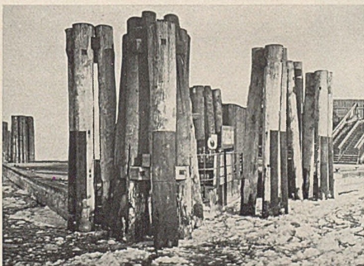
Abb. 16. Aufgelegte Stahlblechplatten zum Schutz gegen mechanische Abnutzung.
