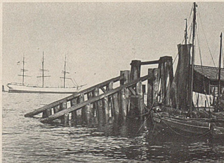
Abb. 25. Ältere Form des Eisbrechers.
