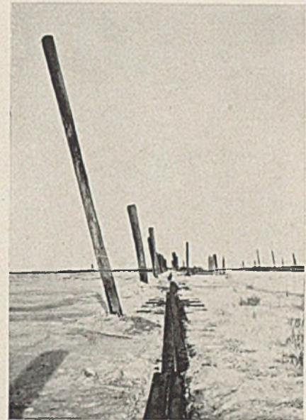
Abb. 35. Durch Eisdecke ausgezogene Pfähle im Holzhafen.
