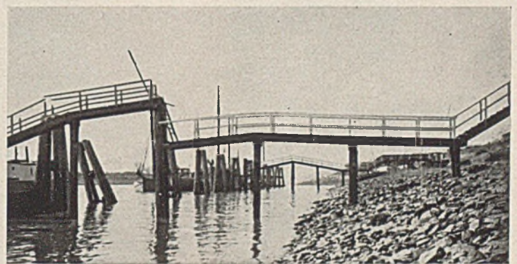
Abb. 36. Wirkung der Eisdecke im Tidegebiet auf Wassertreppen u. Dalben.
