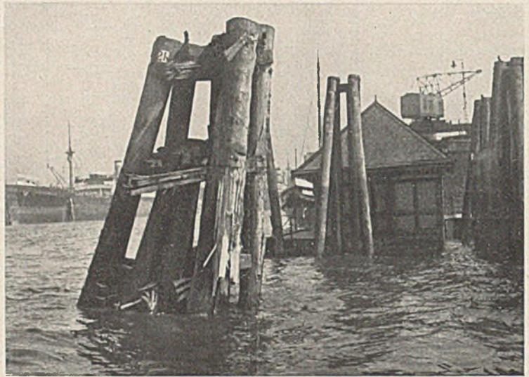
Abb. 30. Zerstörter Schutzdalben mit 3 Verbänden.
