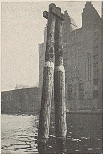
Abb. 38. Ummantelung von Pfählen nach Entfernung des faulen Splintholzes.
