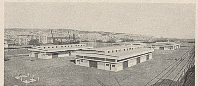
Abb. 5. Blick auf die neuen Schuppen.
