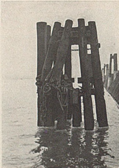
Abb. 39. Aus morschem Dalben herausgerissene Haltekette.
