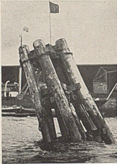
Abb. 29. Zerstörter Vertäudalben.
