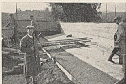
Abb. 14. Gitterplatte des Widerlagers einer Reichsautobahnbrücke. (Blick auf die verlorene Schalung).
