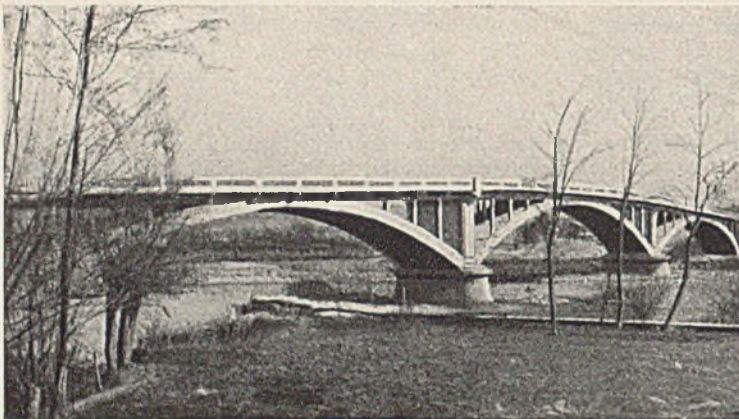
Abb. 1. Blick auf die Brücke von Pouilly sous Charlieu.
