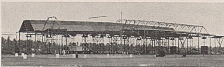
Abb. 12. Montage der Flugzeughalle 85 m mit teilweise aufgelegter Dachhaut.
