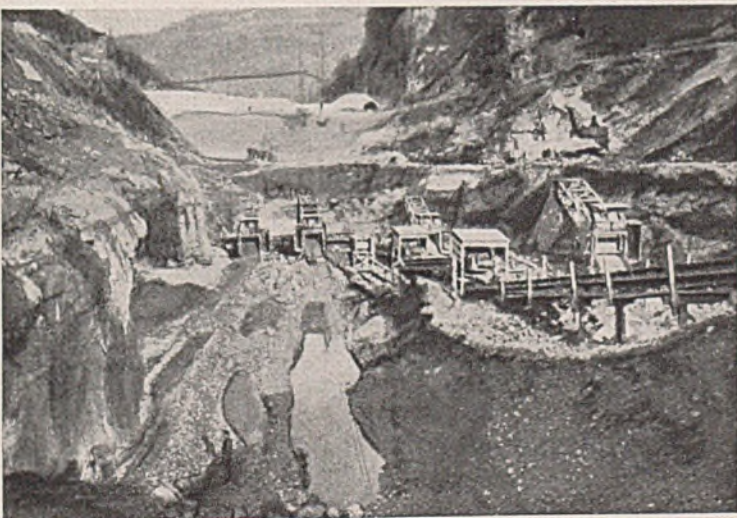
Abb. 3. Ansicht der Baustelle zur Zeit des Abtrags der Anschwemmungen.
