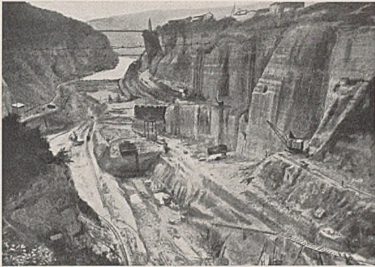
Abb. 1. Gesamtansicht der Baugrube, aufgenommen am 10. Sept. 1941 vom linken Steilufer gegen das Unterwasser.
