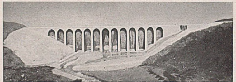
Abb. 3. Ansicht der Unterwasserseite der Staumauer.
